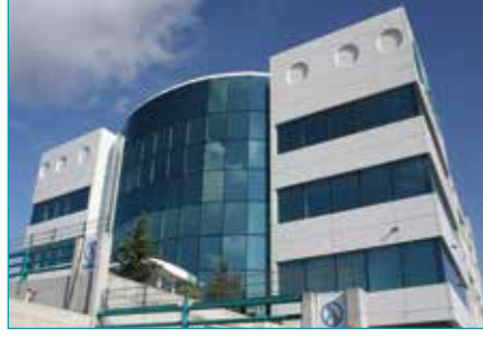
Arfen İnşaat A.Ş. / İSTANBUL
