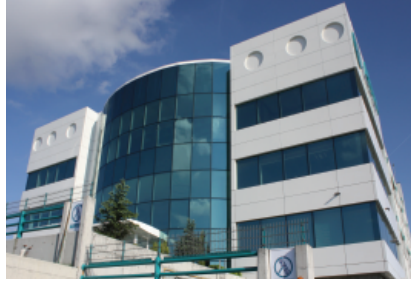
Arfen İnşaat Yapı Teknolojileri / İSTANBUL
